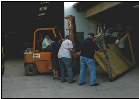
Bau des Holzstegs im Hof der Firma Algesheimer
